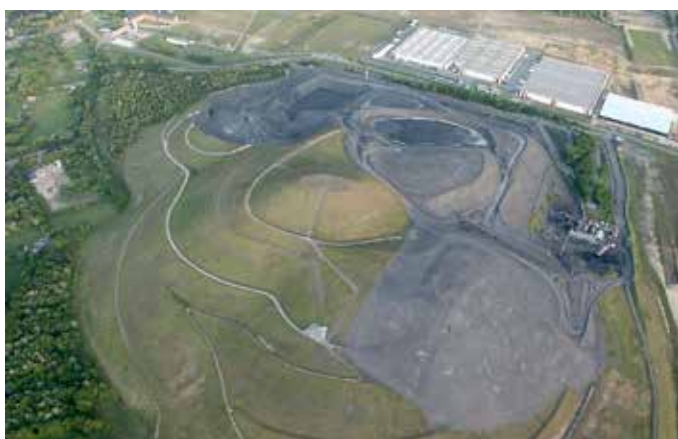
Fig.4. Luchtfoto van de heraangelegde terril van Winterslag, met zones waar de mijnsteen werd afgegraven en opnieuw gestort © https://c-mine.be/terril-winterslag
