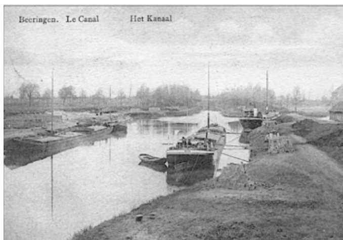
Fig. 20. IJzererts op de kade van de kleine Beringense havenkom.
