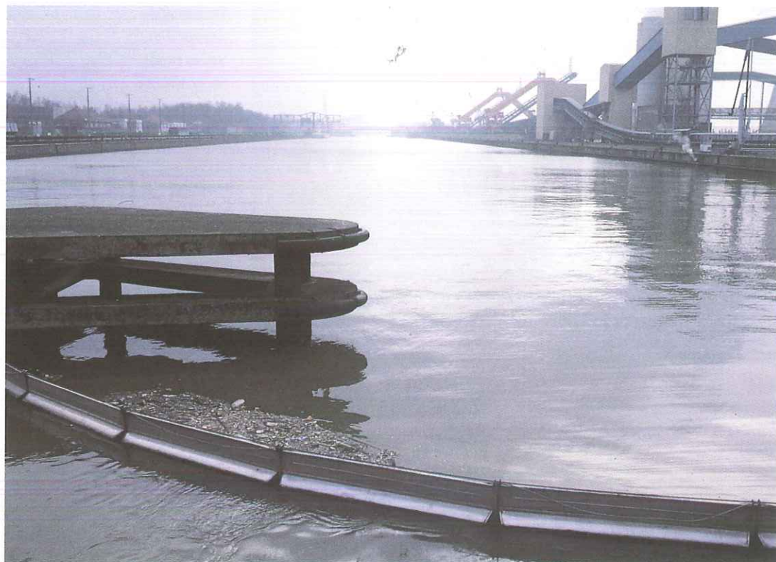
Koelwaterinnamepunt van de Electrabelcentrale te Langerlo in de Kolenhaven.
