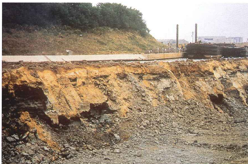
Figuur 1 De graafwerken aan het Albertkanaal te Briegden; ontsloten zijn de Zanden van Alde Biesen en de Nucula-klei.
