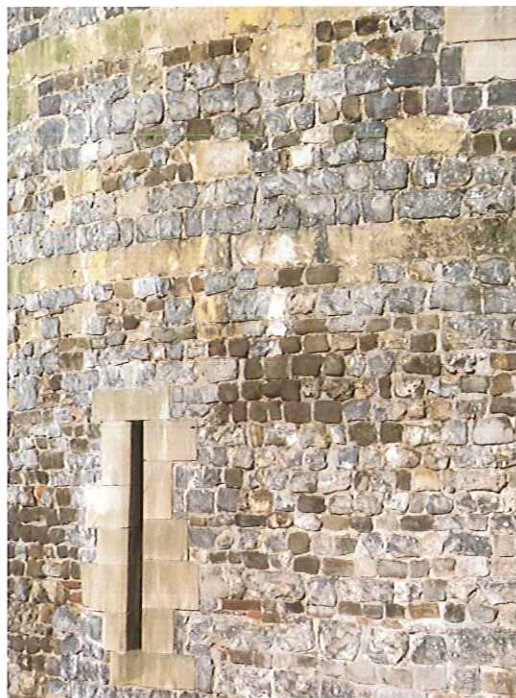
Figuur 11 : Mozaïek van zandsteen (bruin), silex (grijs), kalktuf (beige), rode baksteen (Romeinse dakpannen) en strogeel Maastrichts korrelkrijt ("mergel") in de recent gerestaureerde Velintoren uit de Middeleeuwse stadsomwalling (13e eeuw) van Tongeren.
