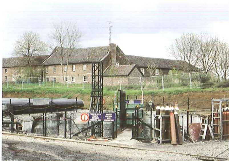
Foto 1 : Toegangsschacht voor de tunnel onder de Maas voor de gaspijpleiding, gelegen achter de Elvenschans op een afstand van 35 tot 50 meter van de waterput en de historische fontein.
