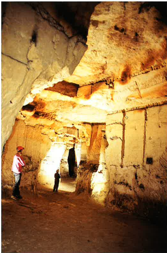
Figuur 3. Rechthoekige doorsneden van gangen in het diepere gedeelte van de Grote Kuil, waar vrijwel geheel de Kalksteen van Nekum ontgonnen is. (foto David De Roest)
