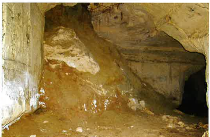
Figuur 8. Instortingszone, vermoedelijk van een doline die gevuld was met Tongeriaanzand (herkenbaar aan de groene kleur) met dakbreuk (grote, bleke blok kalkareniet). De boomwortels tonen aan dat de oppervlakte niet veraf is; Champignonskuil. (foto Michiel Duser)
