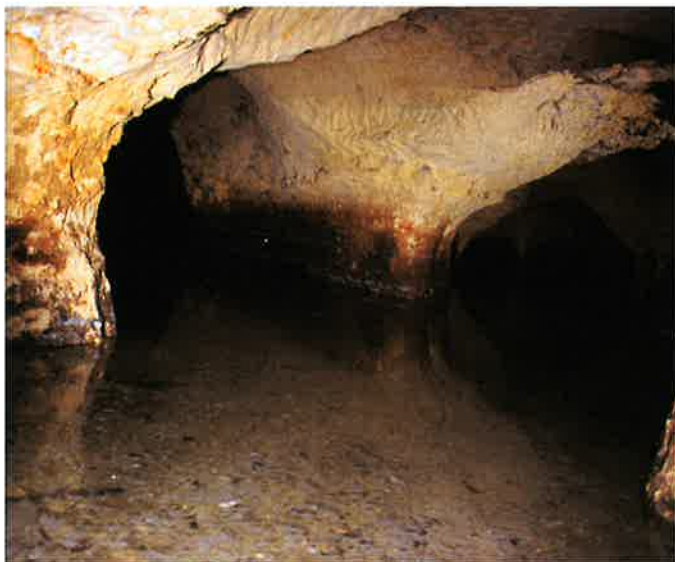
Figuur 4. Boogvormige doorsneden in de Waterkuil, waar Kalksteen van Meerssen ontgonnen is. (foto David De Roest)
