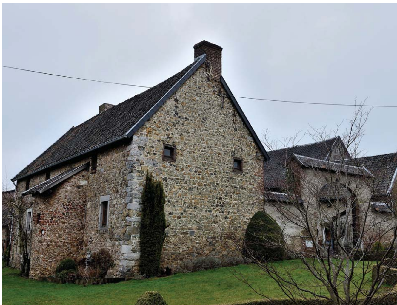
Deze hoeve in Voeren is met vuursteen gebouwd. Rechts: prehistorische artefacten uit het vuursteenatelier van Rullen. FOTO'S RIK PALMANS/MAURICE HEUS
