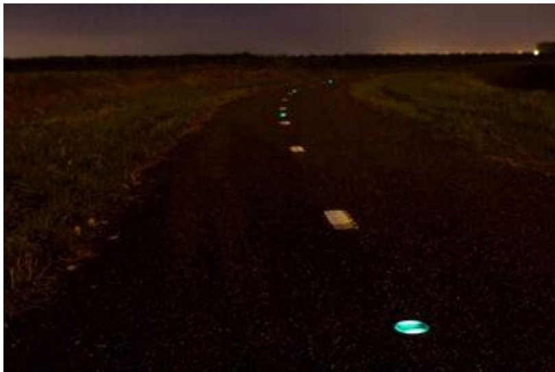
Figuur 42: actieve wegmarkering via 'glowstuds' in een fietspad. Foto: mobiliteitsplatform.nl
