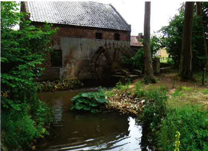
Figuur 9. Ingang van de vispassage op de Itterbeek aan de Kasteelmolen (Foto Thierry Gaethofs)
