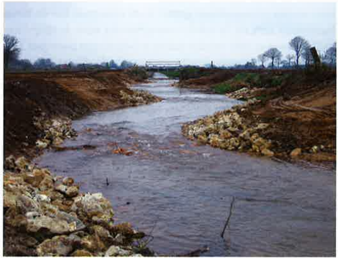
Figuur 30. Vispassage op de Itterbeek vlak na aanleg in maart 2011 afwaarts het Schurchthof (Foto Jos Trouwen)
