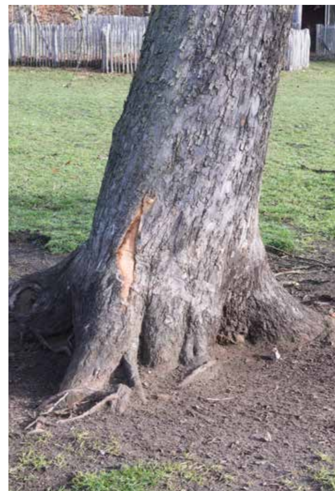
Figuur 5. Schade aan de stambasis en betreding door vee
