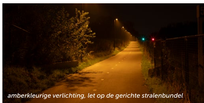
overgang van amberkleurige verlichting naar actieve wegmarkering
