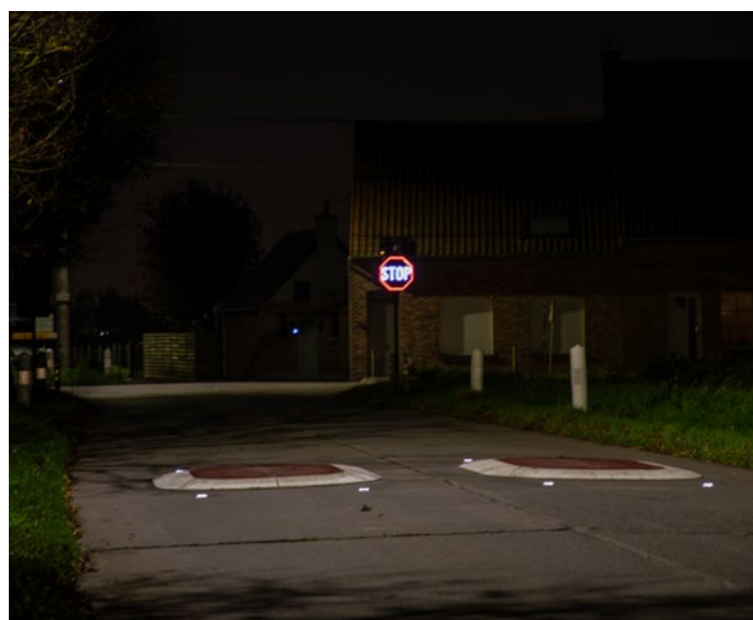
Actieve wegmarkering duidt verkeerdrempels aan en oplichtend stopbord
